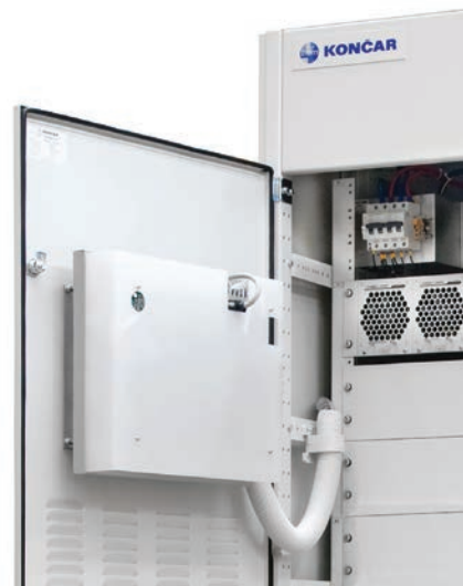
Upravljačka jedinica KONLOG u ormaru
